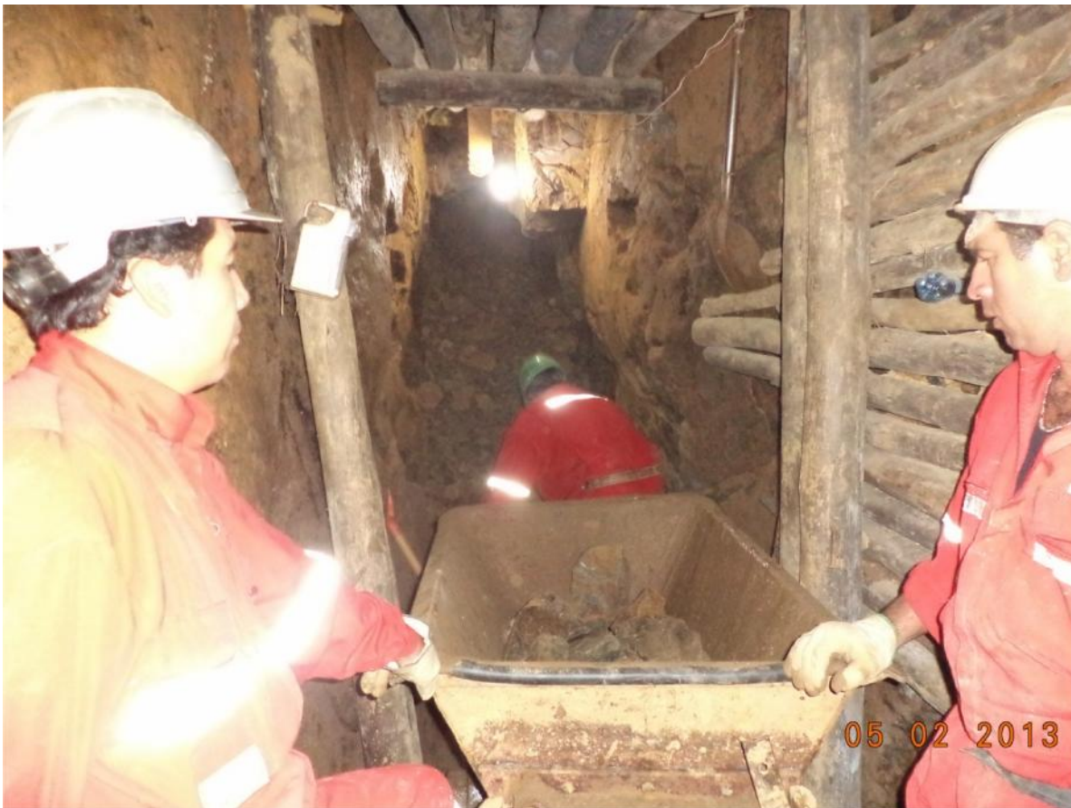
Extracción y fortificación chimenea número 4.
